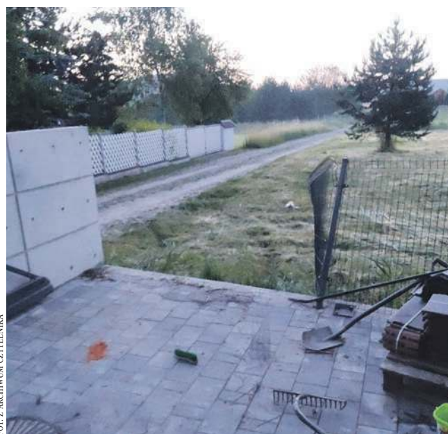
Zniszczone ogrodzenie posesji, z której złodzieje ukradli samochód
