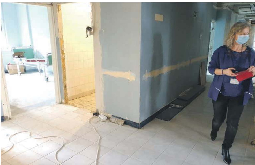
Urszula Bogdan, zastępca dyrektora ds. infrastruktury i logistyki w chrzanowskim szpitalu, na remontowanym oddziale psychiatrycznym
