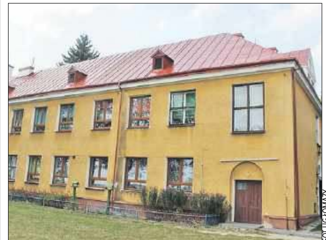
Umowa na remont pokrycia dachu Szkoły Podstawowej w Huszcy w gminie Łomazy podpisana
