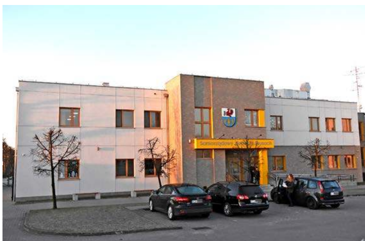
Widok na Samorządowy Żłobek w Brusach.
