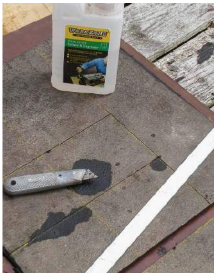
Rysunek 18. Po wyschnięciu „kanapki” można ją ciąć przy użyciu noża Stanleya i metalowej, prostej listewki
