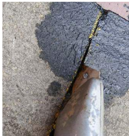
Rysunek 19. Smarowanie ostrza noża zapobiegającego jego zakleszczaniu się
