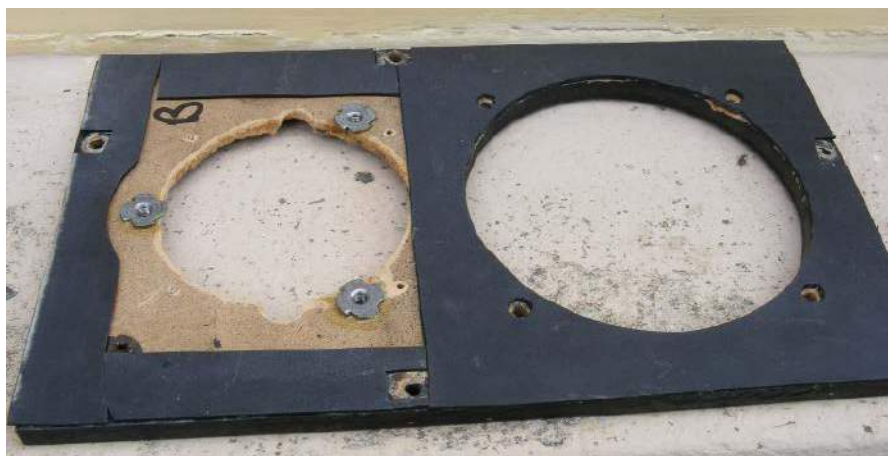
Rysunek 5. Nakrętki łkowe (typu T) założone dla głośnika wysokotonowego T27 z tyłu ścianki (wewnątrz obudowy). Ponieważ T27 jest montowany z przodu, zgrabnie zakrywa „surowe” wycięcie
