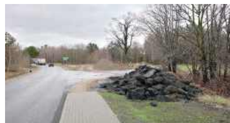
Droga Wola Sernicka - Kaznów w trakcie realizacji inwestycji
