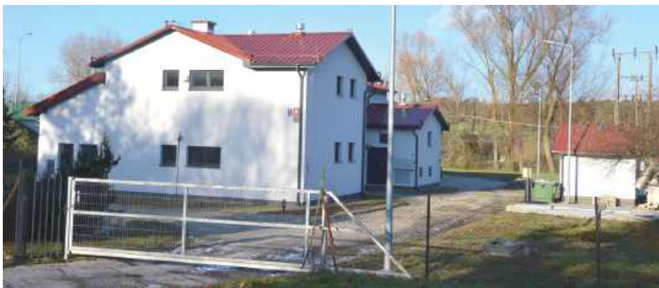
Spółka Bionor wygrała przetarg na zaprojektowanie i wykonanie rozbudowy oczyszczalni ścieków w Chodlu. Umowa zawarta została w sierpniu 2021 roku. A roboty odebrane w maju 2023 roku
