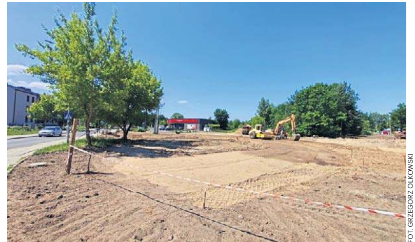
Niebawem mieszkańcy będą oglądali rondo o 45-metrowej średnicy
