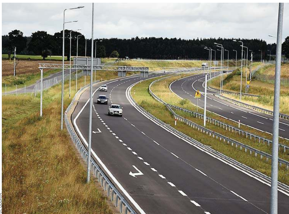
Początkiem drogi ekspresowej S5 w naszym regionie jest wybudowany już odcinek Ornowo – Wirwajdy
