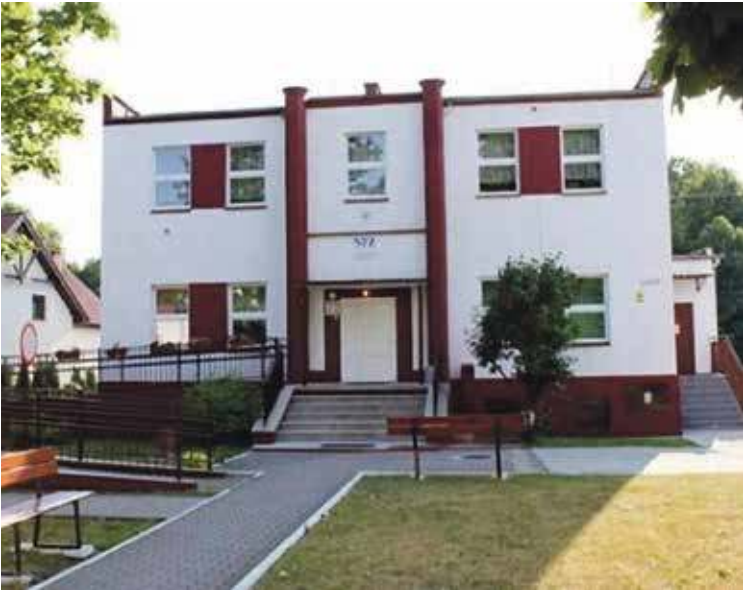
Ośrodek będzie remontowany. Poprawi się komfort personelu i pacjentów.
