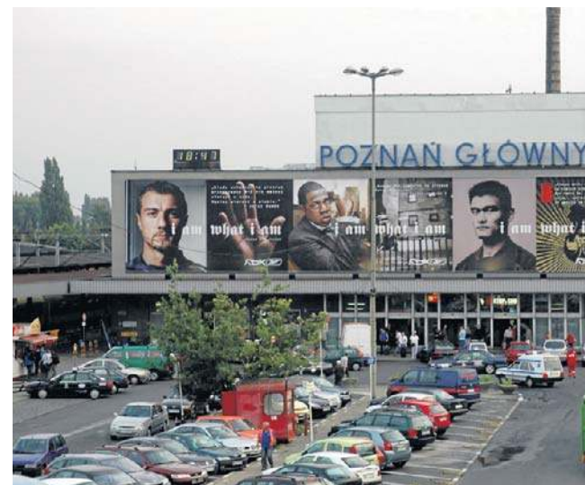
Poznań Główny w 2005 roku. Za PRL-owską fasadą kryją się pozostałości oryginalnej elewacji z 1879 roku
