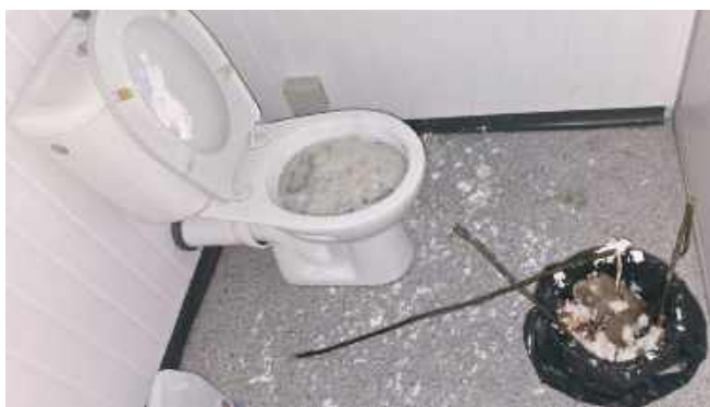
■ Wandalizm przy Orliku w Nędzy. Gmina pokazała skutki zniszczeń i zaapelowała o reagowanie na akty dewastacji. FOT. UG NĘCZA
