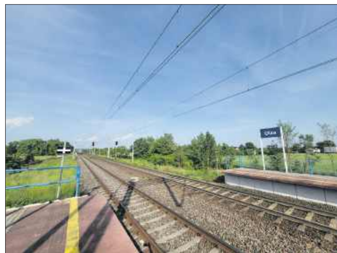
■ Linia 176 kończy bieg w Olzie, nieopodal stacji kolejowej
