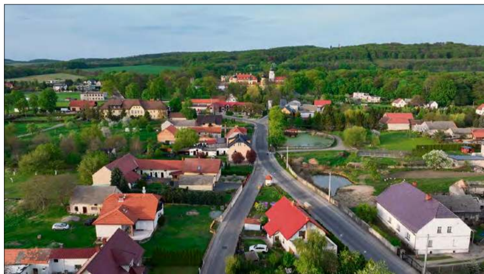
Spółka WiK w Zdzeszowicach realizuje inwestycję dla mieszkańców gminy korzystających z usług zaopatrzenia w wodę i odbioru ścieków.
