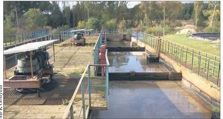
Oczyszczalnia ścieków znajduje się w północno zachodniej części miasta
