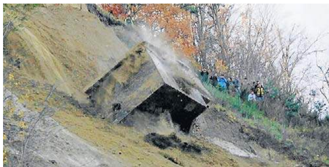
50 ton betonu spadło z klifu. Tak wyglądała akcja z 2012 r.
