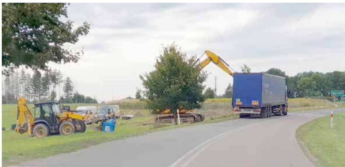
Początek budowy. Ciężki sprzęt na miejscu pojawił się wczoraj, w poniedziałek
