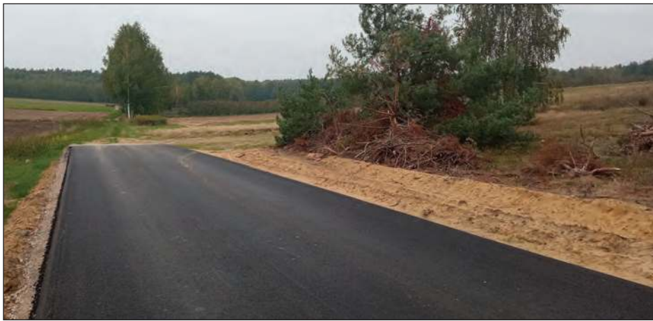
Nowa droga wprawdzie nagle się urywa, ale zdaniem wójta Nowodworu, inwestycja jest potrzebna i wykonano ją poprawnie
