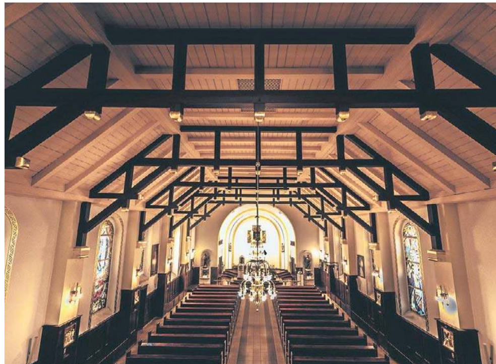
Belki umieszczone pod sufitem nie tylko podtrzymują dach, ale pełnią też rolę ozdobną
