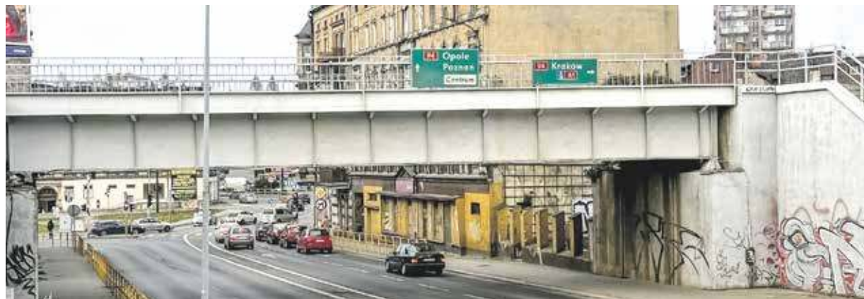
Rozbiórka wiaduktu była skomplikowanym przedsięwzięciem
