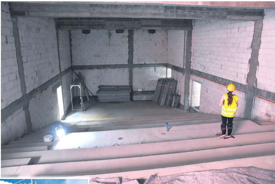
Sala kinowa ma już dach, widać, jak będą ustawione fotele. Przestrzeni jest tam sporo.
