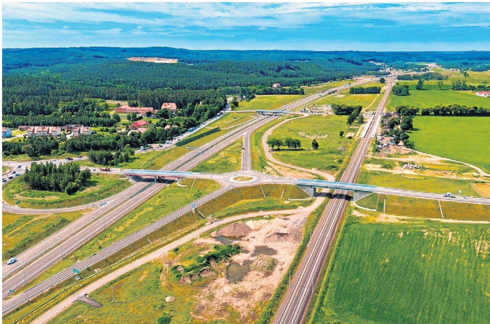
Zwienieczeniem prac było oddanie do użytku 40-kilometrowego, ostatniego brakującego fragmentu S6 z Leśnic do Słupska
