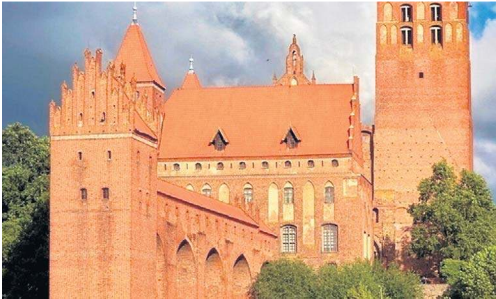
Z zewnątrz prace obejmą dachy i okna. Elewacje nie wymagają remontu
