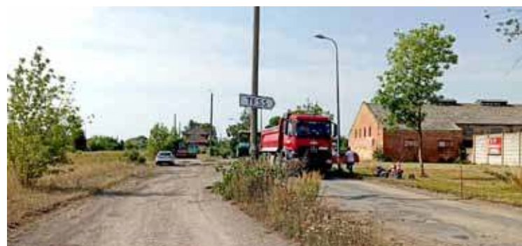
Na ulicy Okulickiego trwają prace drogowe. W poniedziałek kładziona będzie tam masa bitumiczna
