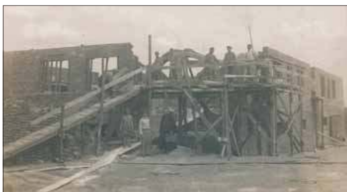
Ksiądz Wincenty Przebinda z Ignacym Kadłubickim przy placu budowy, lata 1946-1950
