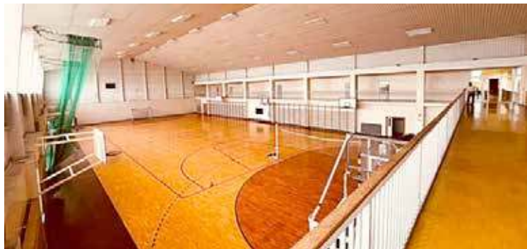
Jedną z planowanych inwestycji jest przebudowa hali SP nr 3
