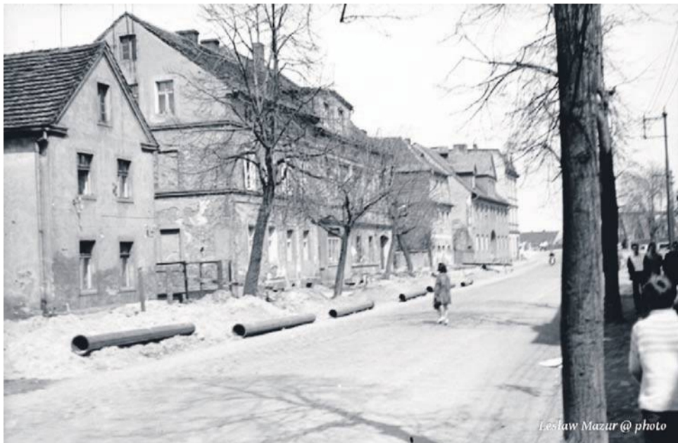
Rok 1968. Lewa strona idąc do Odry, te budynki zostaną wyburzone z wyjątkiem ostatnich dwóch
