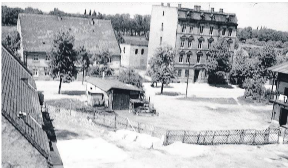
Rok 1968. Zdjęcie zrobione z budowy nowego budynku na ul. B. Chrobrego nr 35-71. Po prawej widać kawałek budynku z balkonami. Po lewej stodoła - w tym miejscu powstanie „Kwadraciak”. Na wprost mały parterowy pawilon to kuźnia kowala Józefa Muńkowskiego. W tym budynku 3-piętrowym za ulicą na dole mieszkali rodziny oficerów sowieckiej armii, a na górnych piętrach był szpital dla żołnierzy
