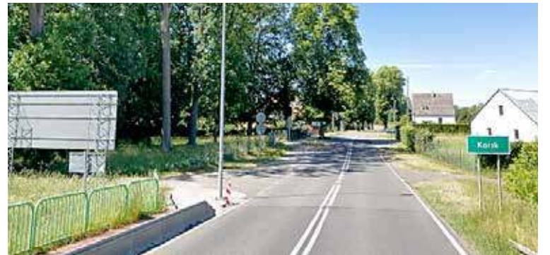
Dla części mieszkańców Karska budowa kanalizacji w miejscowości nie jest najważniejszą inwestycją
