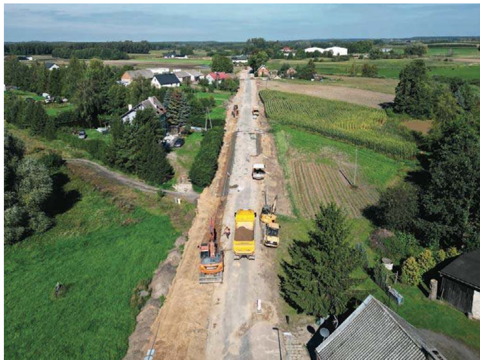
Ciężki sprzęt w akcji. Drogowcy pracują obecnie intensywnie na wysokości Szeplerzyny. Finał robót na odcinku drogi powiatowej od Wiekla do granicy powiatu nowomiejskiego przewidziano jeszcze w tym roku. Inwestycja kosztuje aż 17,5 miliona złotych
