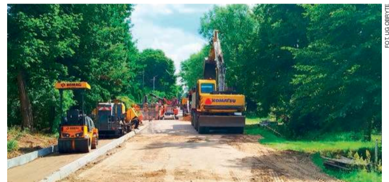
Przebudowa drogi w Sadykrzu
