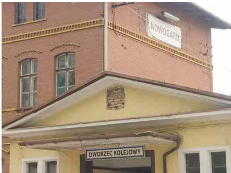
Cieężko jest w PKP doprosić nawet zainstalowania nowego zegara, a co dopiero mówić o całościowym remoncie zabytkowego budynku
