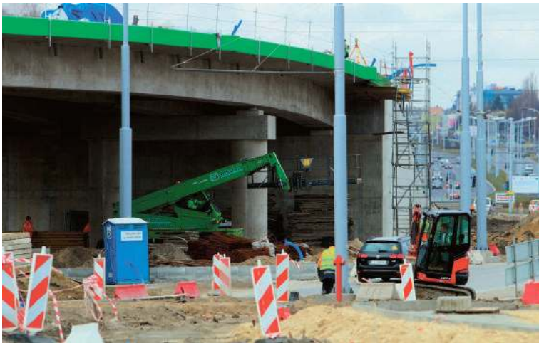
Przebudowa skrzyżowania ulic Krochmalnej i Diamentowej
