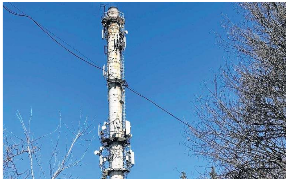
Komin na terenie Przedsiębiorstwa Energetyki Ciepłej w Sandomierzu to alternatywne miejsce dla nadajnika
