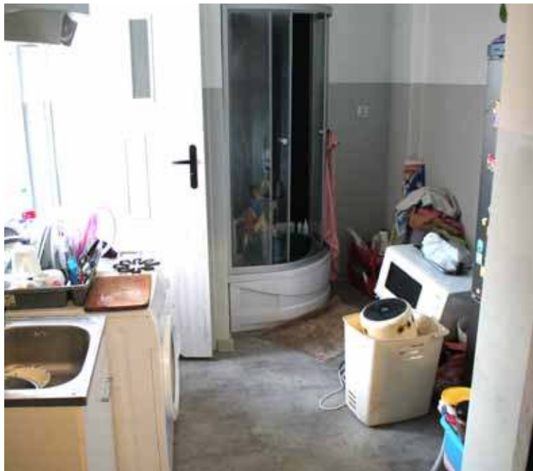
Kabina prysznicowa znajduje się w kuchni. Nie ma podłączenia do stałego źródła ciepła.
