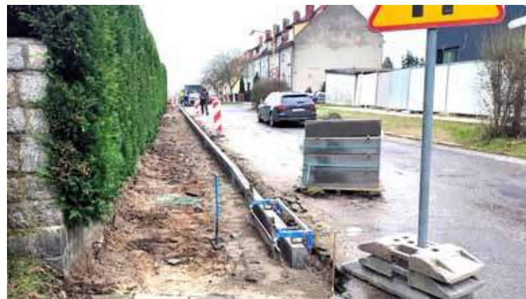
Ruszyły prace wzdłuż ulicy Paderewskiego
