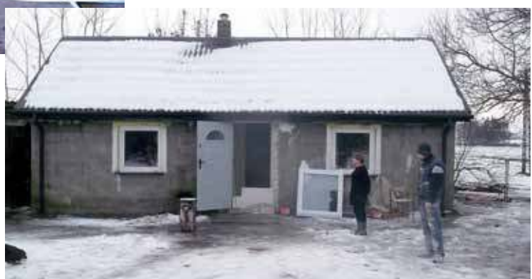
Ten dom po odbudowie
