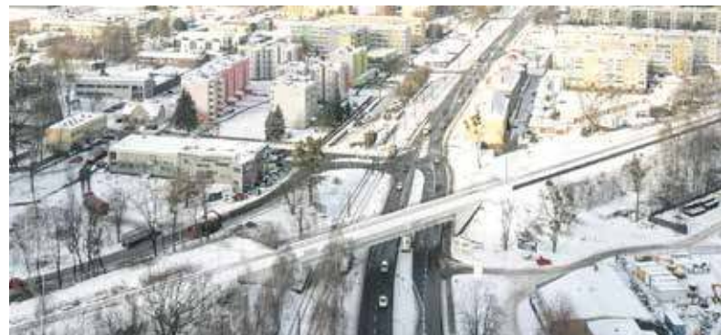
Pierwsze z centrów powstanie w rejonie wiaduktu nad ul. Strzelców Bytomskich
