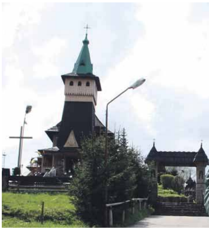
W Witowie, na działce poniżej kościoła parafialnego, powstanie budynek, w którym będzie m. in. ośrodek zdrowia i żłobek.
