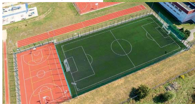
Zmodernizowany Orlik przy SP nr 3 w Ciechanowie
