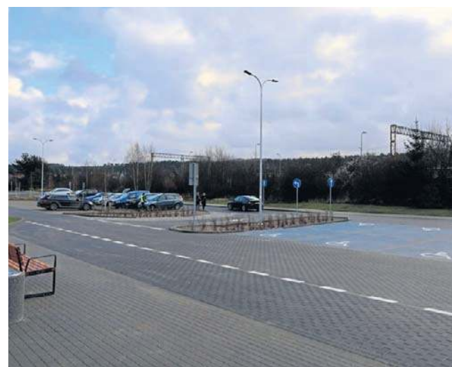
W ramach zadania powstał pokaźnych rozmiarów parking
