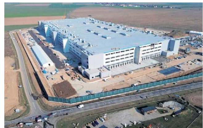
Tak wyglądało centrum logistyczne Amazona pod Dobromierzem jeszcze podczas budowy
