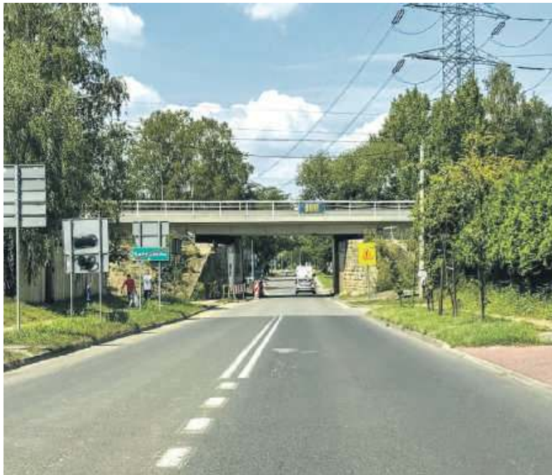
To zdjęcie historyczne, bo stary wiadukt przy Sikorskiego został zburzony
