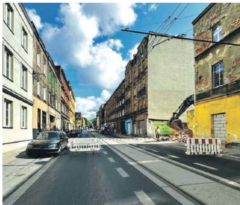
Prace wyburzeniowe prowadzone są z zachowaniem ostrożności
