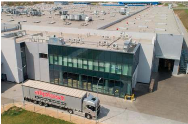
Budynek Aliplastu Sp. z o.o., ul. Wacława Moritza 3, Lublin
