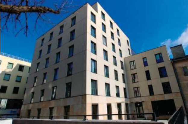
Budynek mieszkalny wielorodzinny z lokalami usługowymi „LUBARTOWSKA 72a”, ul. Lubartowska 72a, Lublin Budynek mieszkalno – usługowy, ul. Uściługowska 21, Chełm Zespół budynków Bulwary Park, ul. Hetmańska 73 i 75, Rzeszów
