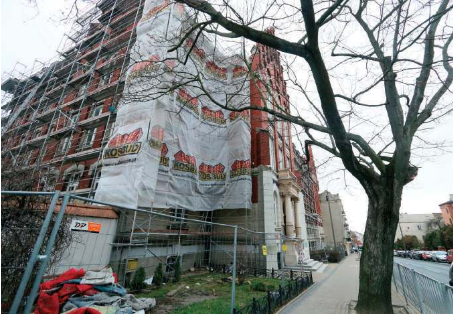
Remont zabytkowego budynku „Vetterów” będzie droższy niż zakładano
