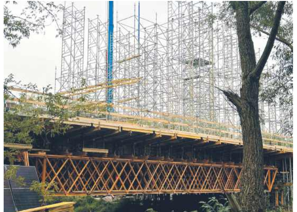
Budowa przeprawy mostowej
