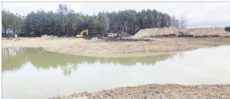
Na ukończeniu jest także budowa zbiornika retencyjnego, który znajduje się w Tucznę na 135-hektarowym areale. Jest to zbiornik o powierzchni lustra wody ponad 1,5 ha z malowniczą wyspą. Ma służyć retencji, ale również rekreacji
