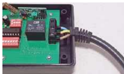
Fotografia 2. Odpowiednie wprowadzenie przewodu do obudowy za pomocą odgiętki
