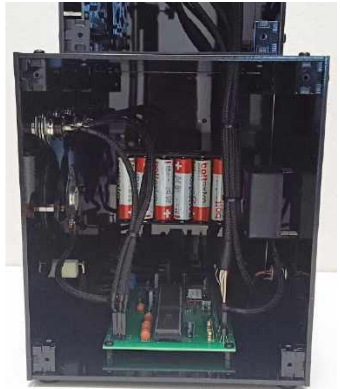
Fotografia 7. Spięcie przewodów za pomocą opasek kablowych
