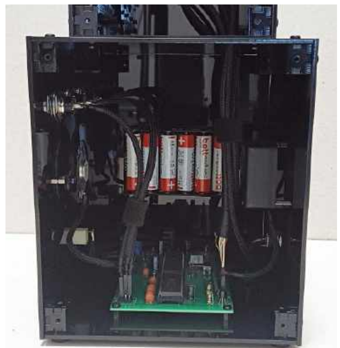
Fotografia 8. Spięcie przewodów za pomocą rzepów
