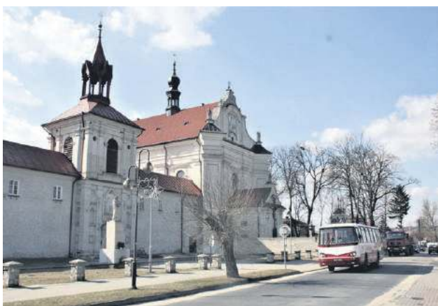
Planowana jest także budowa kanalizacji ściekowej na krasnobrodzkiej osiedlu „Podklasztor”.
