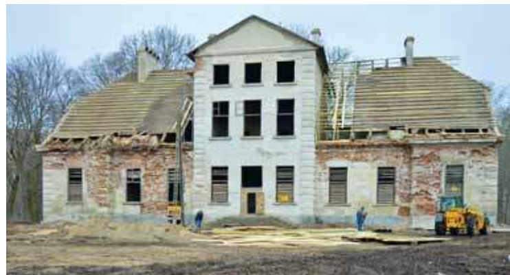
Pałac w Bieżuniu w trakcie ubiegłorocznych prac związanych z zabezpieczeniem dachu
