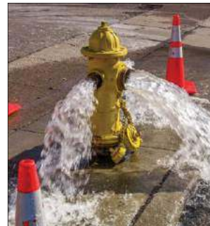
Pojawiające się zaniki ciśnienia na sieci wodociągowej i okresowe przerwy w dostawie wody spowodowane są nielegalnym poborem wody z hydrantów zewnętrznych
