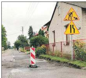
Gmina Łomazy poinformowała, że rozpoczął się remont ulicy Szkolnej. We wrześniu dzieci przyjadą do placówki dobrą drogą
