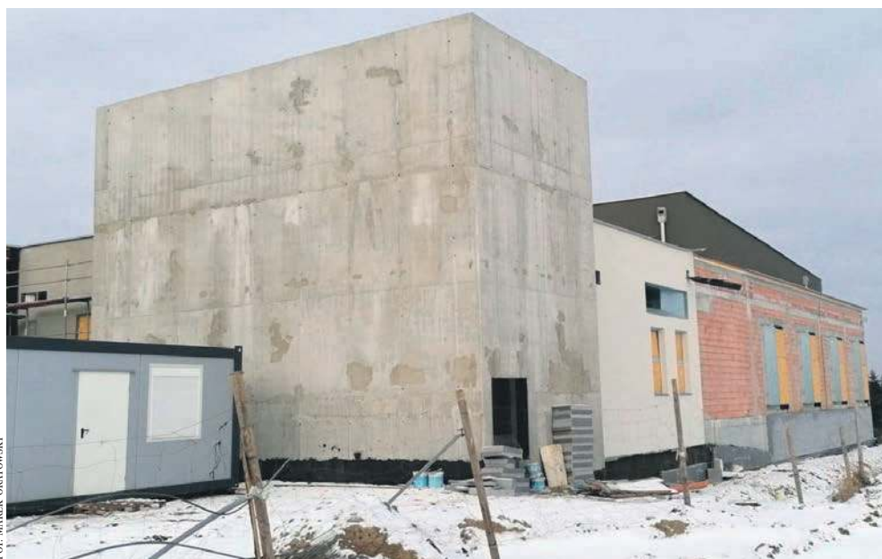
Zakończenie budowy basenu nastąpi wiosną 2022 roku
