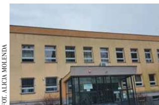
Po remoncie szkoła muzyczna ma się przeprowadzić do budynku po szkole podstawowej przy Borelowskiego
