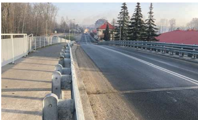
Jak na razie, szanse na oświetlenie wiaduktu są niewielkie
