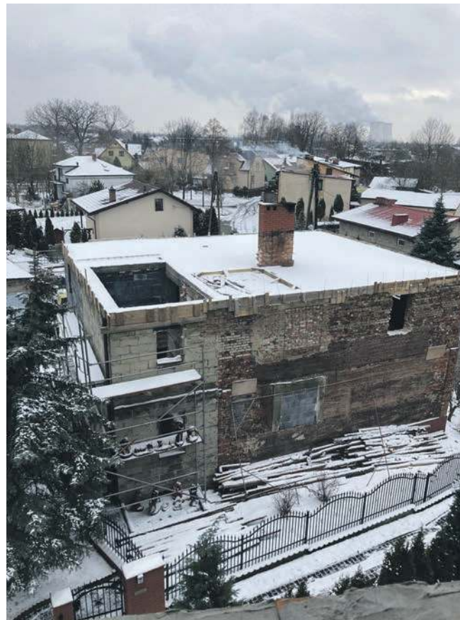
Byli bezdomni pracują przy remoncie i przebudowie drugiego domu Stowarzyszenia Betlejem
