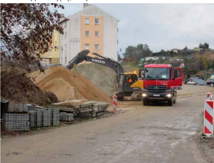
Praca na budowie wre.
