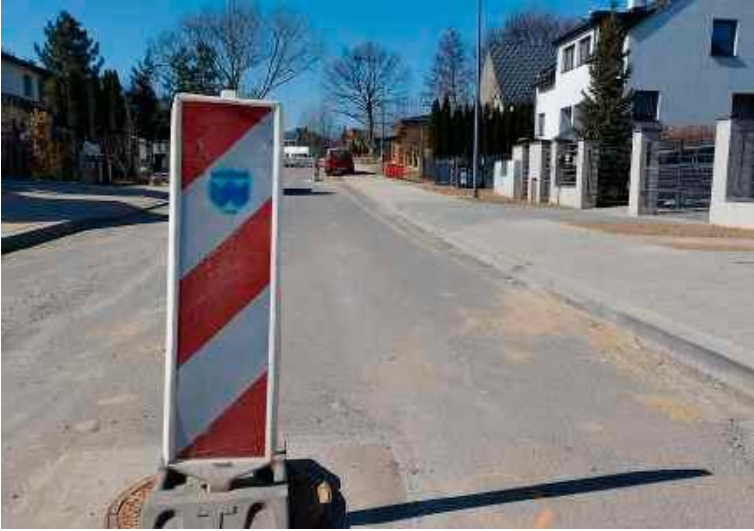
Budowa ulic Leszka i Ziemowita już niemal na finiszu
