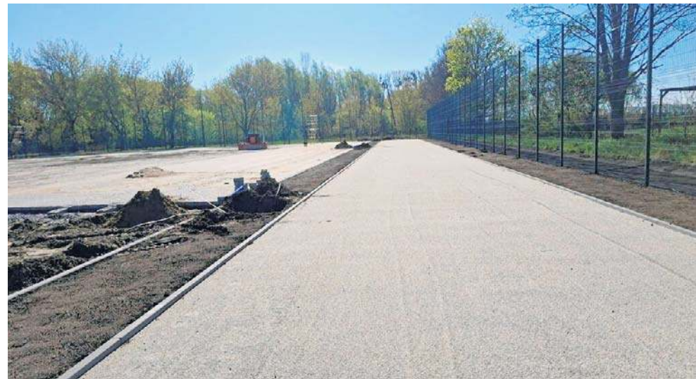
Prace przy budowie kompleksu sportowego przy Szkole Podstawowej im. Jana Pawła II w Ptaszkowie idą pełną parą
