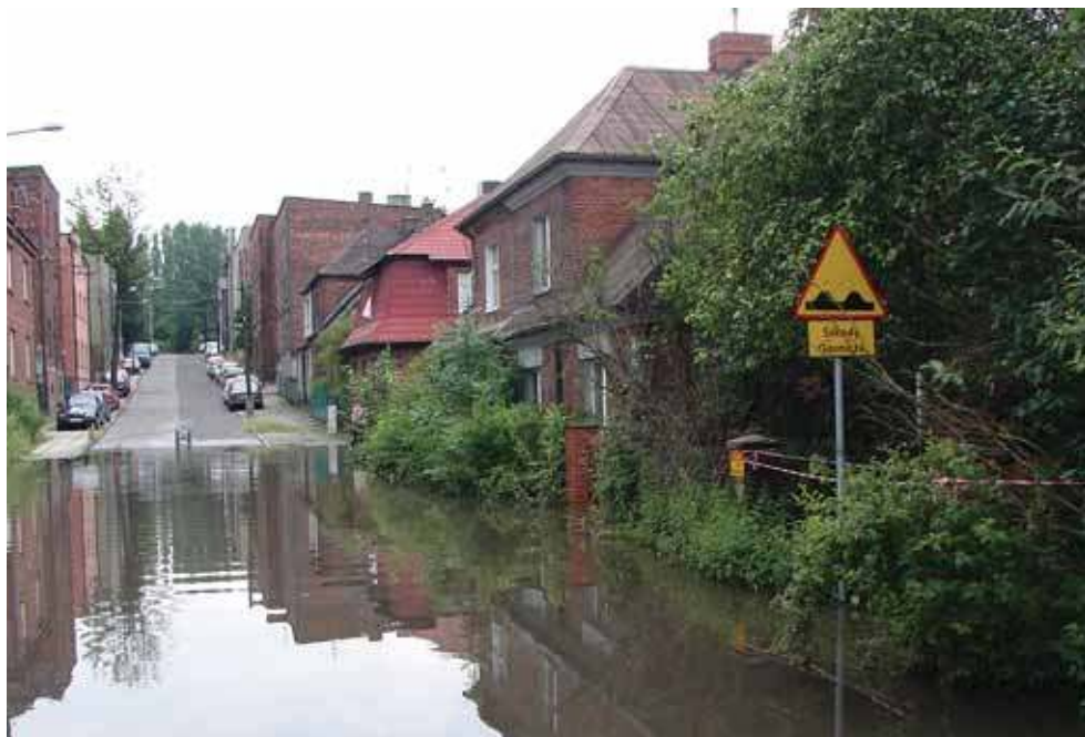
Fot. 20. Zalewisko w Katowicach po intensywnych deszczach nawalnych
