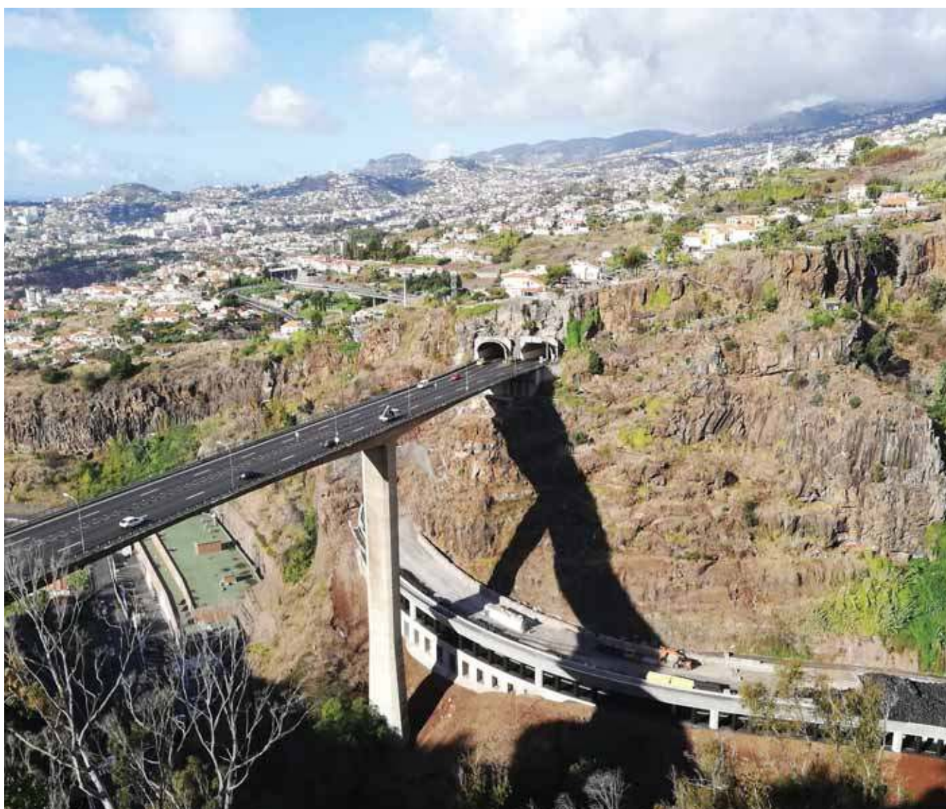
Fot. 8. Funchal - budowa dróg w górzystym terenie to duże wyzwanie
