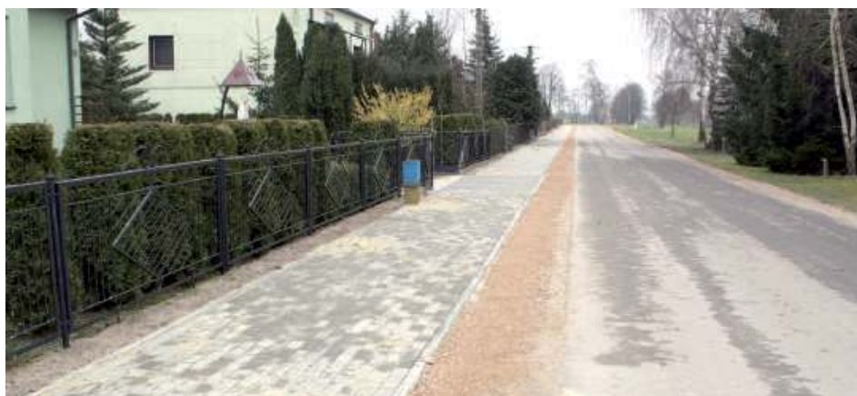
Już w marcu mieszkańcy Żakowoli Poprzecznej mogli cieszyć się z chodnika na odcinku gminnym
